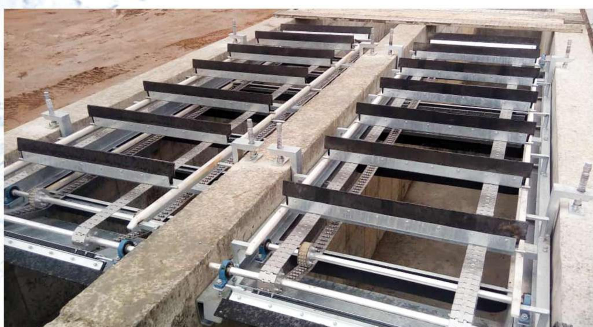
قطعات خیس شونده اسکیمر شامل پاروها، زنجیر و شافت ها از استیل ضدزنگ و جنس بدنه فولاد با پوشش گالوانیزه گرم می باشد. اسکیمر چربی برای محدوده گسترده ای از حوضچه های مستطیلی قابل ساخت می باشد.
