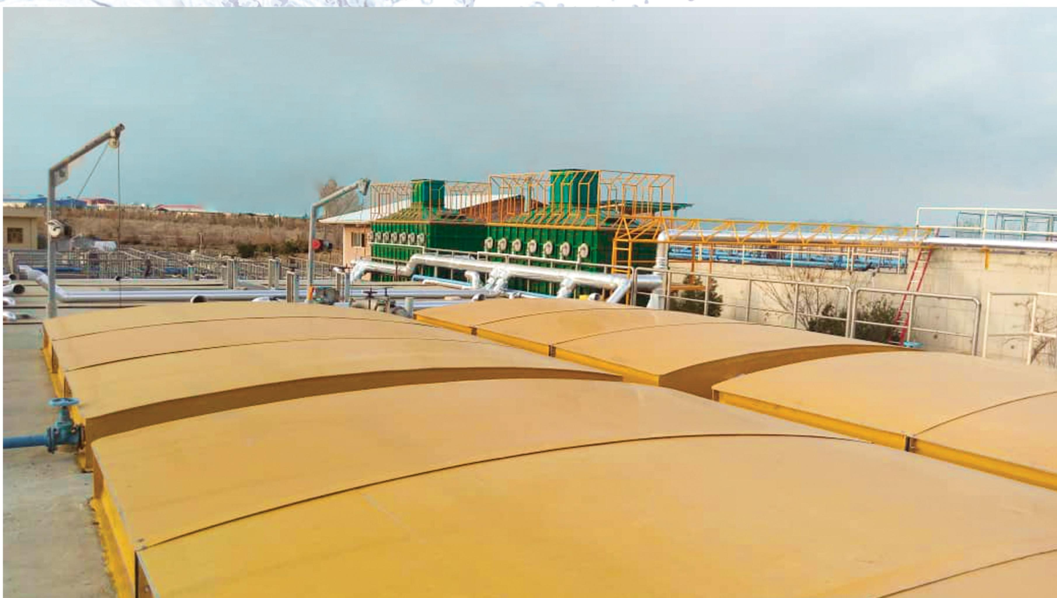
شرکت طرح و توسعه پژوهش محور به منظور حل مشکلات گفته شده در بالا اقدام به طراحی و ساخت سقف‌های مورد نیاز در تصفیه‌خانه‌های آب و فاضلاب از جنس کامپوزیت تقویت شده با الیاف شیشه (GFRP) نموده است. سقف‌های GFRP بر طبق ابعاد حوضچه موجود و یا سفارش مشتری به صورت قوسی و یا تخت قابل اجرا می‌باشد. علاوه بر سقف‌های گفته شده، ساخت انواع ورق‌های آجدار GFRP نیز امکان پذیر می‌باشد که می‌تواند جایگزین مناسبی برای ورق‌های آجدار فولادی یا گریتینگ‌های فولادی باشد.
